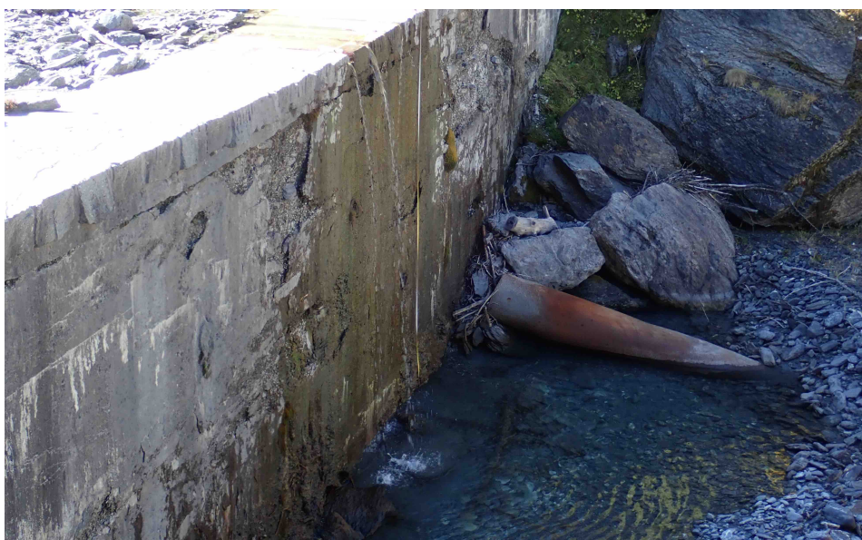
(b) Degrado del paramento di valle
