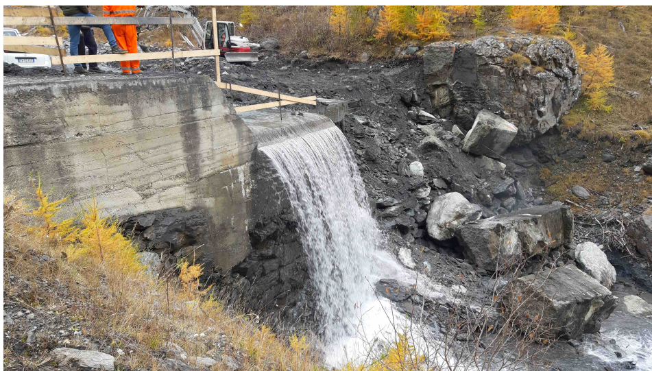
(a) Crollo durante i lavori di consolidamento
