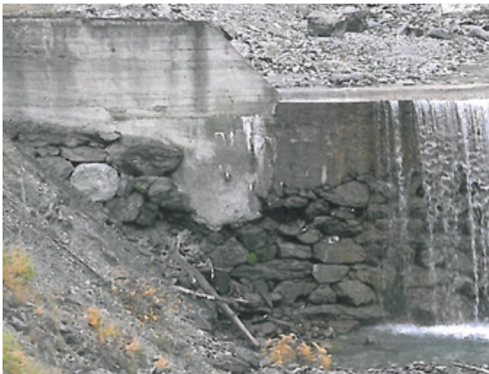
(a) Dettaglio dell'ammaloramento del paramento di valle, in orografica sinistra
