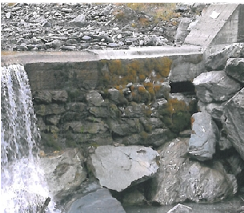
(b) Stato di degrado in orografia destra
