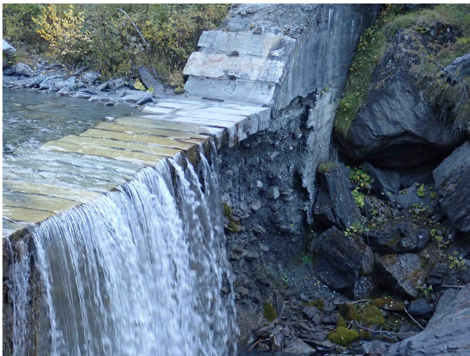
(a) Dettaglio dell'ammaloramento del paramento di valle
