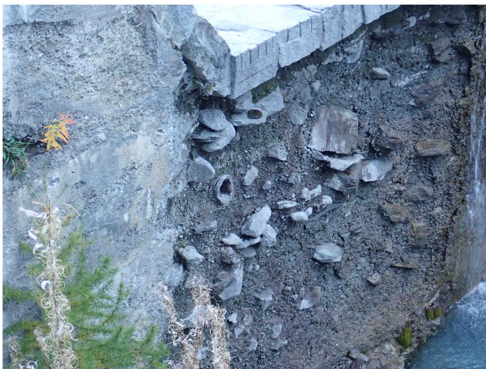
(b) Dettaglio dell'ammaloramento del paramento di valle
